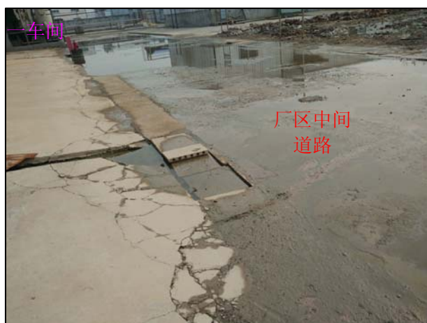
建设雨污分流之前
